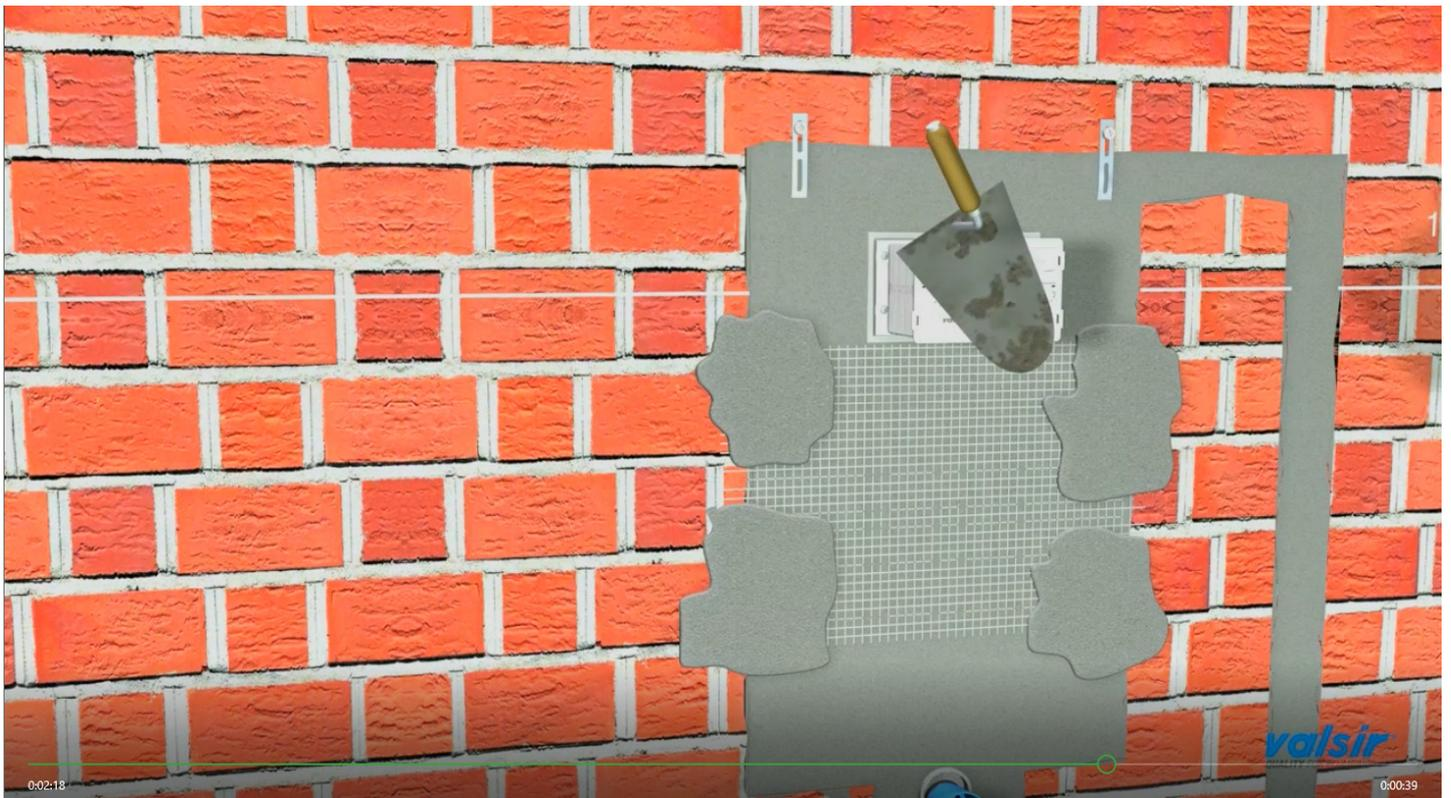
以混凝土鋪至平滑，但必須留住維修口(生口位)及沖水喉的位置，這2位置千萬不可入混凝土！
