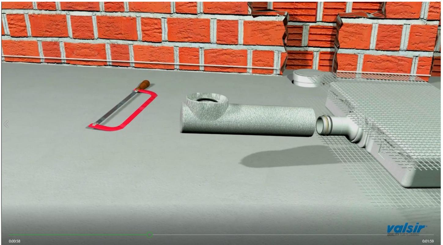
把沖水喉套在水箱腳的喉管接駁位置，確保沖水喉沖水口扭至正面。
