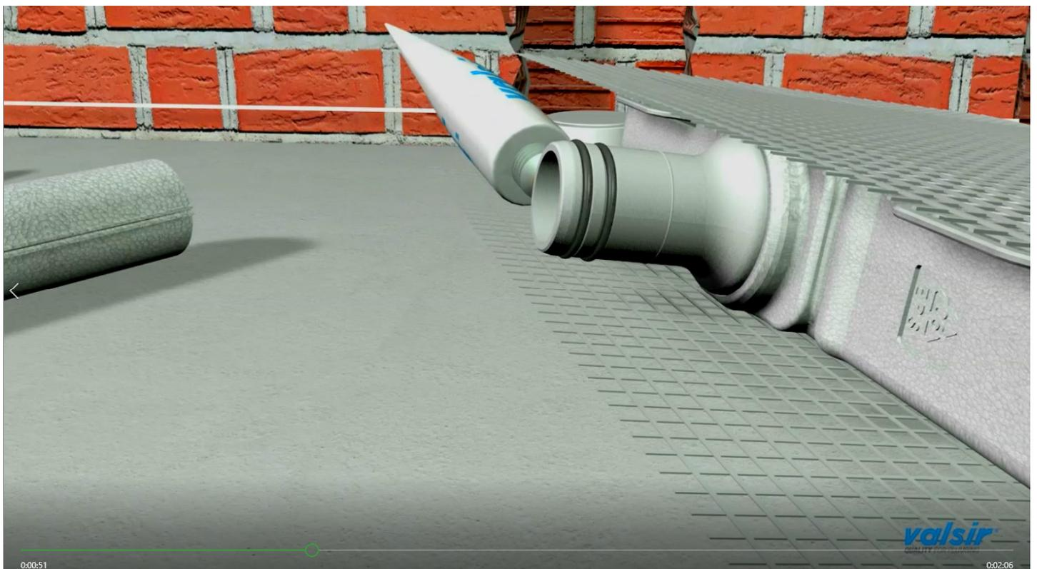
在水箱腳的喉管接駁位置塗上潤滑劑 / 雪油，讓喉管更易套入。
