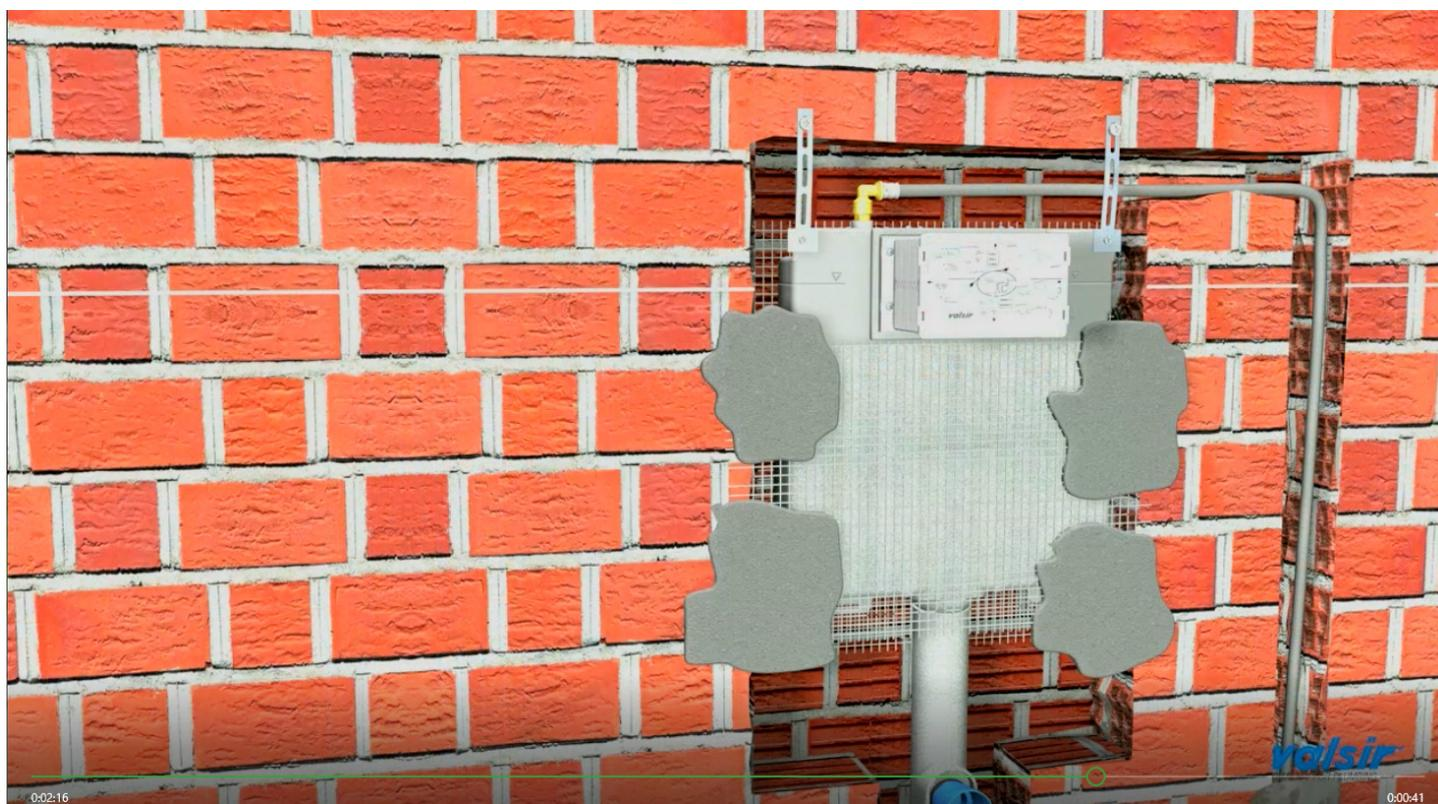
確認水箱已安裝完、固定好後，用防蟲鼠塞把沖水喉封好，先以混凝土固定水箱主體圖中的四個位置，再繼續封入混凝土。
