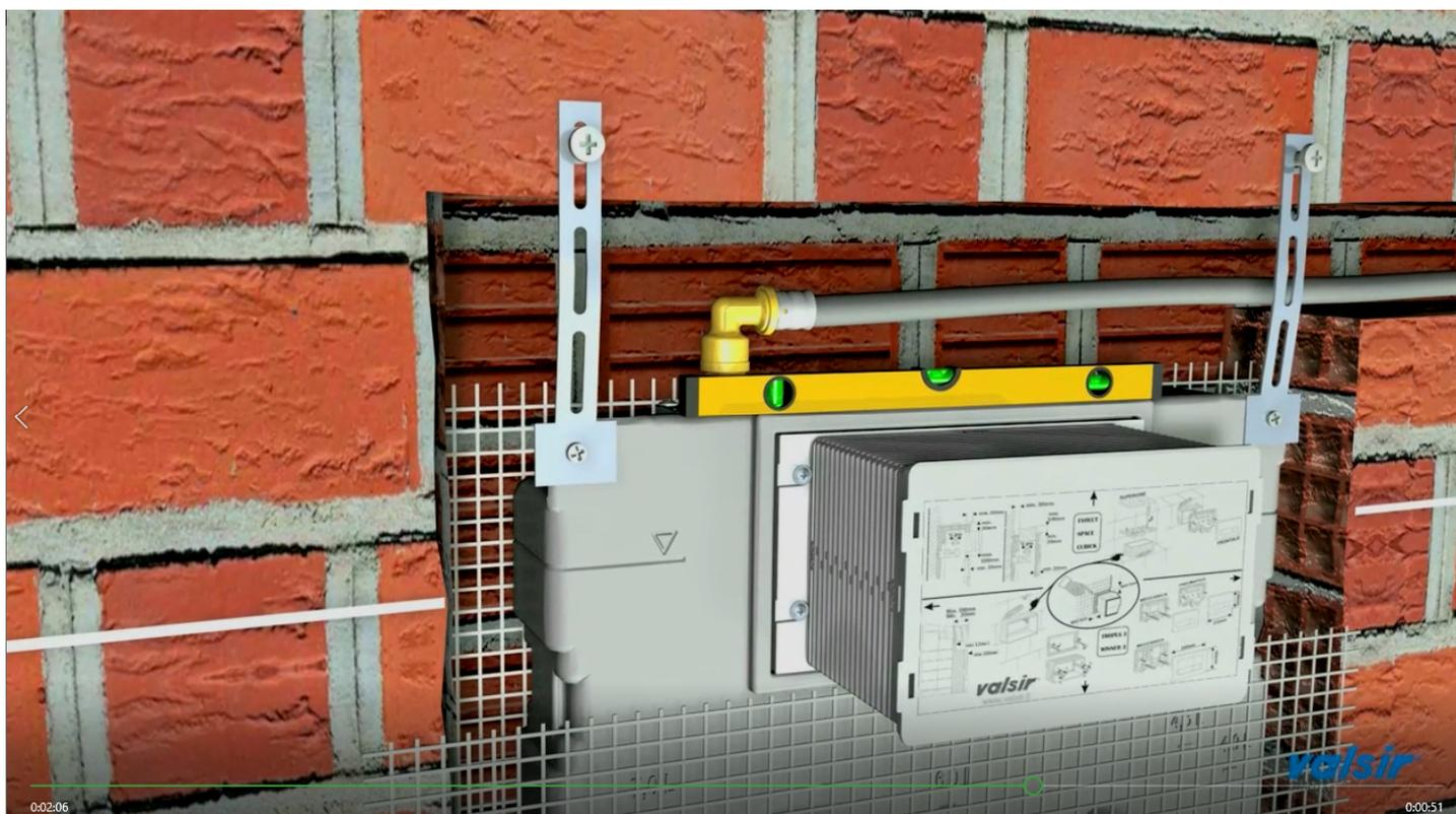
使用平水尺，確保水箱為水平狀態。
