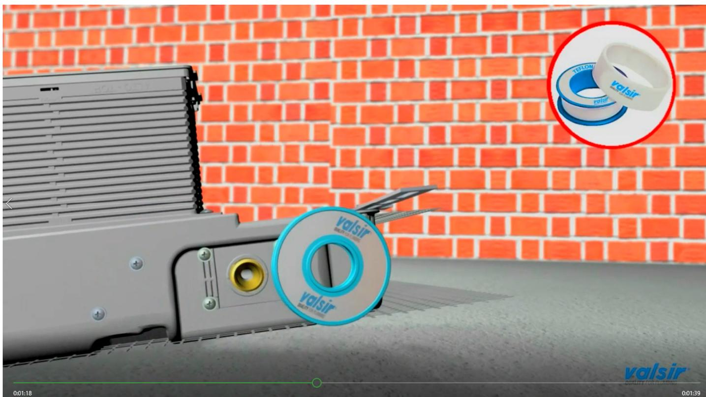
在入水口位置纏上士粘膠布。(香港使用海水沖廁，為免部件氧化，所以水箱盡量不會使用片中的金屬部件，而是特製塑膠製品。)
