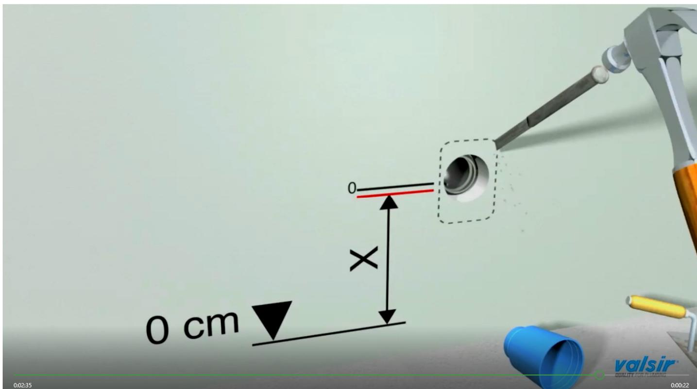
把沖水喉的防蟲鼠塞拔走，鑿走邊位位置的混凝土。
